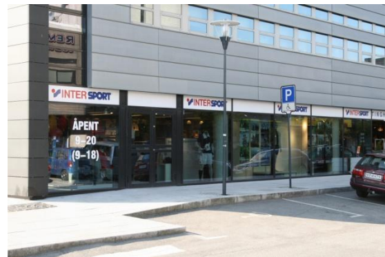
Godt og bredt fortau utenfor tinghuset med transparent fasade. Stor høydeforskjell fra fortauet ned til gaten.
