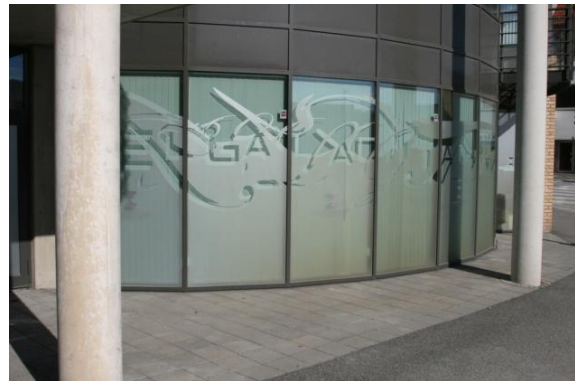
Fasaden med vinduene på hjørnet av bygningen i krysset mellom St. Olavs gate og Oalsgaten er helt avskjermet med foliering og lamellgardiner.
