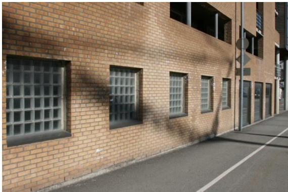
Fasaden mot St. Olavs gate fremstår som avvisende og lukket.
