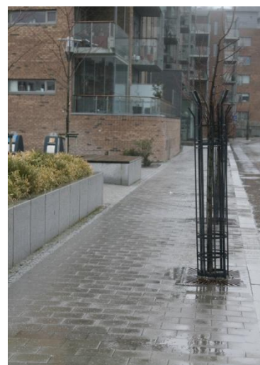
Her kan en se at boligblokkene har et halvplan hvor 1. etasjen er hevet i forhold til gateplanet.
