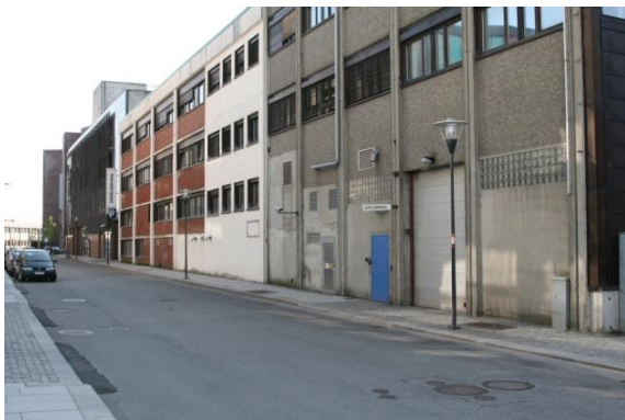
Baksiden av den gamle politistasjonen og parkeringshuset.
