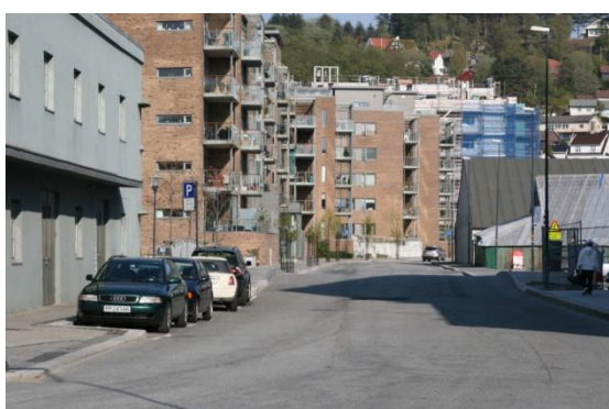
Langsgående parkering med biler gjør at fortauet blir svært smalt utenfor bygningen er ser på bildet. Det er også lite åpenhet fasaden.
