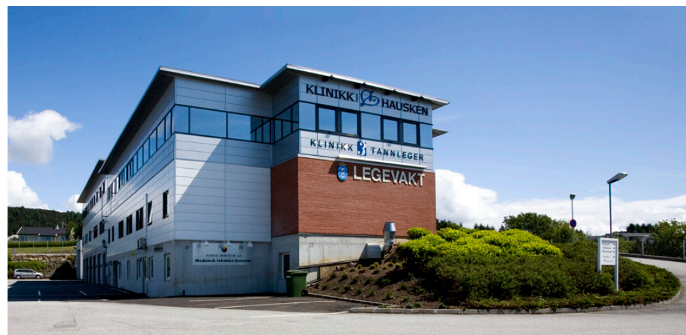
Ill. 28: Legevakten er lokalisert øst i bydelssenteret. Fasaden fremstår lukket, med lite vinduer i øyenhøyde.
