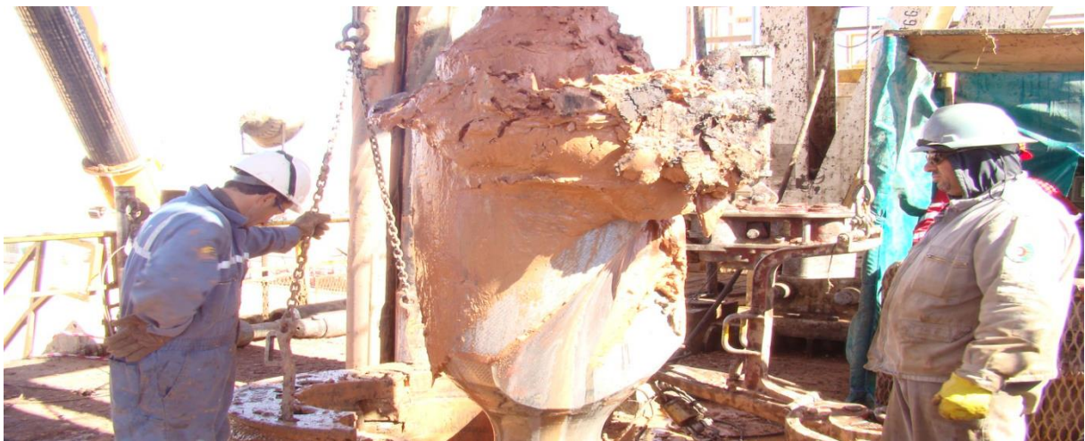
Figur 3-10. Det er et bilde tatt fra en Statoil brønn i Algerie, bildet viser leiren som har hopet seg rundt en stabilisator pga kjemiske reaksjoner, i verste fall må stabilisatoren byttes helt ut [1].
