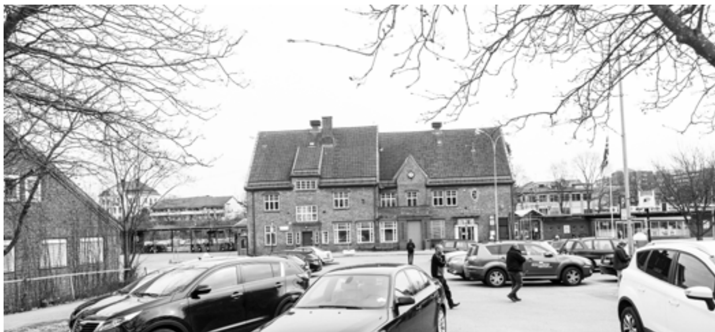
Bilde 1: Dagens stasjonbygg med parkeringsplass og taxiholdeplass i forgrunnen.
