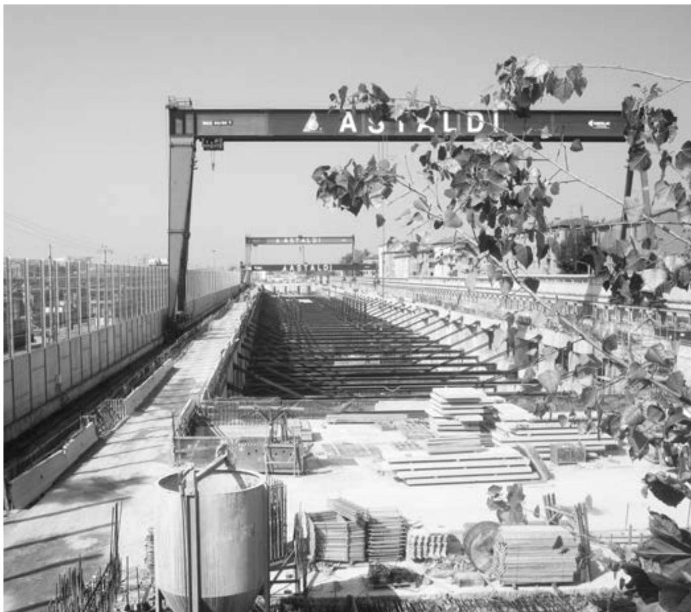
Fra byggingen av ny stasjon i Bologna, Italia. Bildet viser utgravingen av stasjonen, der spunt el. er drevet ned i jorden, og avstivet på tverrs. Når massene i hullet er gravd ut kan man støpe opp plattform etc innvendig og legge på betongelementer til tak og gategulv. Tønsberg stasjon kan bli bygget på en lignende måte. Foto: Ove Skovdahl
