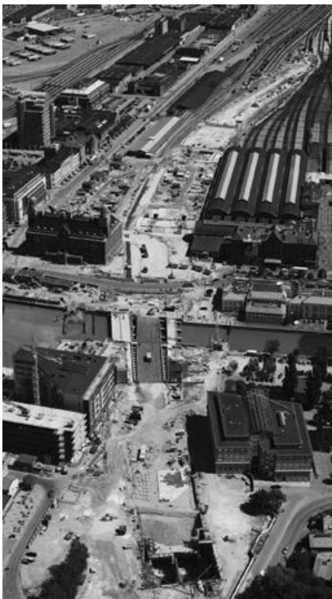
Bilde venstre: Fra byggingen av Citytunneln gjennom Malmö, Sverige. I likhet med prosjektet i Tønsberg ble det her bygd en ny kulvert-stasjon under bakken. Prosjektet ble gjennomført mens den gamle stasjonen på overflaten forble i drift. Foto: Perry Nordeng/Citytunneln
