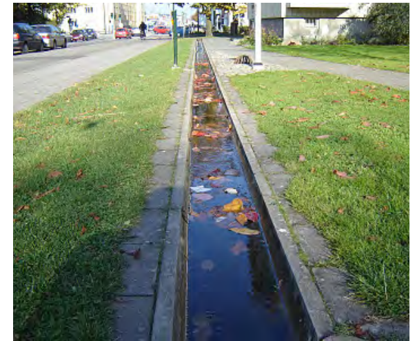
ill. 67.6 - Kanaler for regnvann gir følelsen av å være i naturen selv i tette boligstrøk (fra Ekostaden Augustenborg, Sverige)
