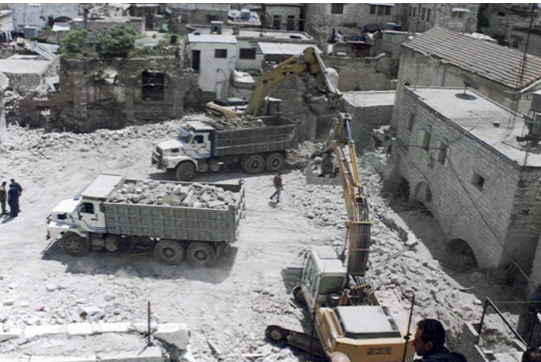
Bilde 3.6 og 3.7 Oppryddningsarbeid etter at to såpefabrikker på planområdet ble bombet
