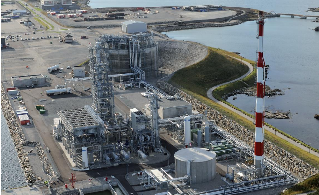
Bilde 2 LNG-anlegget i Risavika ( www.skangass.no )
