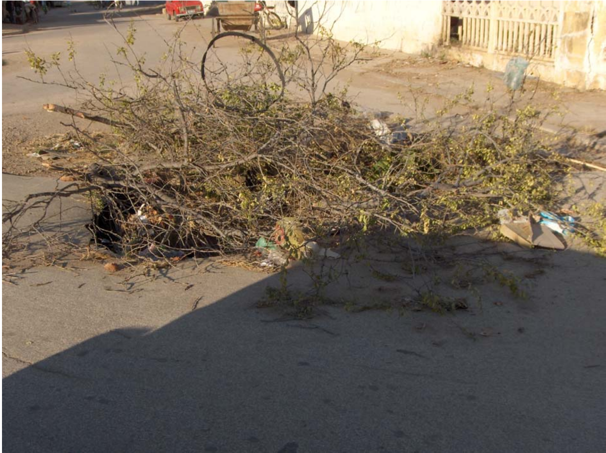
Bilde 3-4 Avløpskanal som er tettet med avfall
