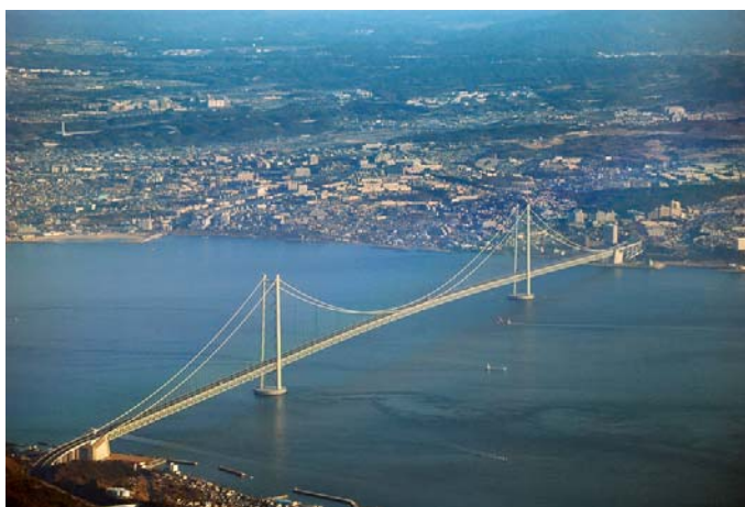
Figur 3-2: Et eksempel på en hengebro er Akashi Bridge, Japan, som er (i 2007) verdens lengste hengebro, fra [3].
