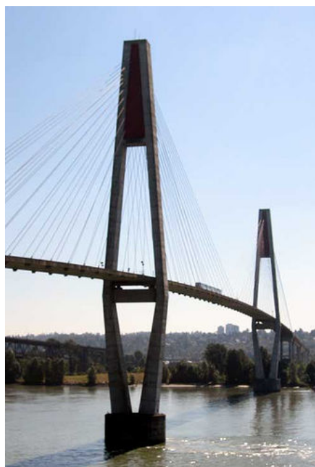
Figur 3-1: Et eksempel på en skråstagbro er Skybridge, den største (i 2007) skråstagbroen i verden som bare bærer kollektivtrafikk, fra [4].
