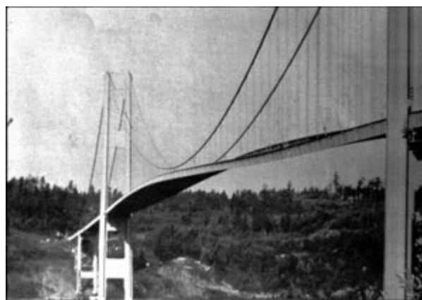
Figur 5-7: Bilde av Tacoma Narrows Bridge like før den kollapset som følge av flutter. Fra [9].
