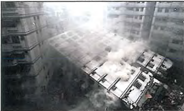
Figur 25, Brudd i fundament av en boligblokk under jordskjelvet i Kobe, 1995 [8].
