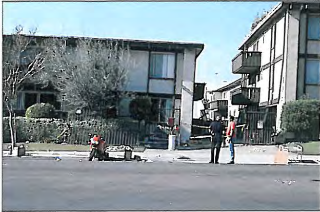
Figur 20, Det store jordskjelvet i Northridge i 1994. I bygget til venstre i bildet har første etasjen kollapset [9].
