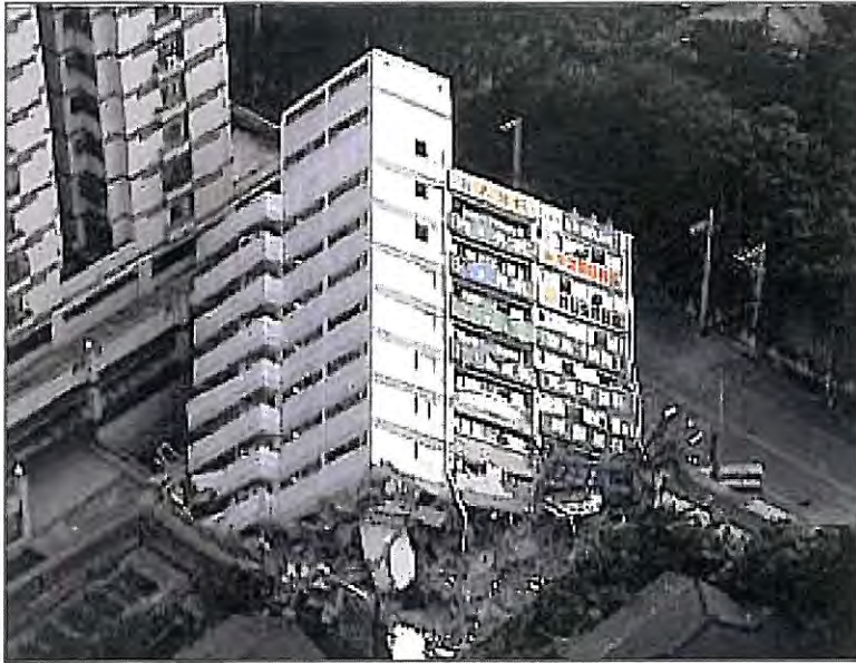
Figur 24, Kollaps av bygg på grunn av brudd i fundamentet [8].
