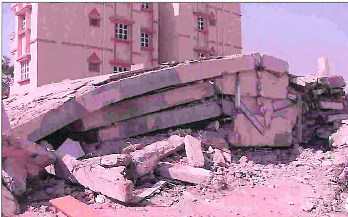
Figur 23, Kollaps av et 4 etasjers skolebygg under det store jordskjelvet i India, Ahmedabad, i 2001. Skjelvet målte 7.9 magnitudo [19].
