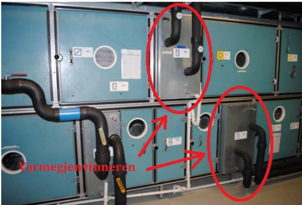
Figur 15 Varmegjenvinnerens plassering i aggregatet
