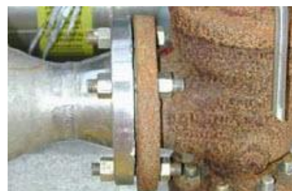
Figur 32: Galvanisk korrosjon
