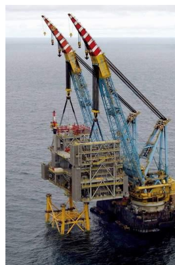
Figur 13: Saipem 7000 under monteringen av BPs plattform Clair
