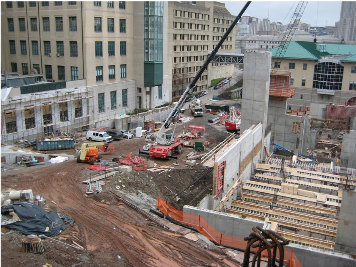
Figur 6-1: Eksempel på en byggeplass hvor det er begrenset med plass tilgjengelig.
