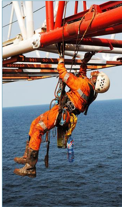
Figur 7.12: Malarbeid på krane offshore
