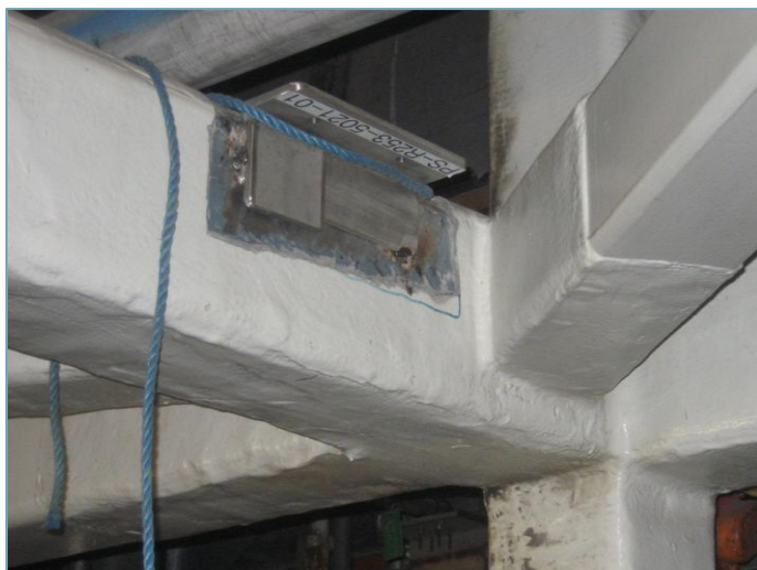
Figur 6.3: Pipesupport ettermontert – maling og Chartek fjernet
