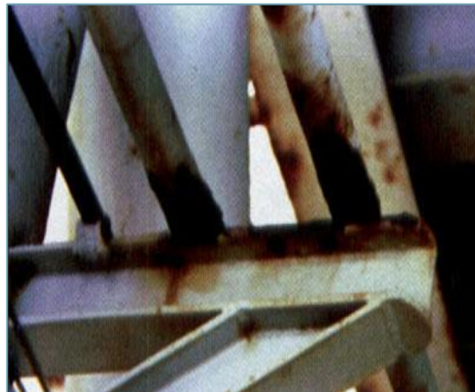
Figur 6.0: Korrodert stålstruktur
