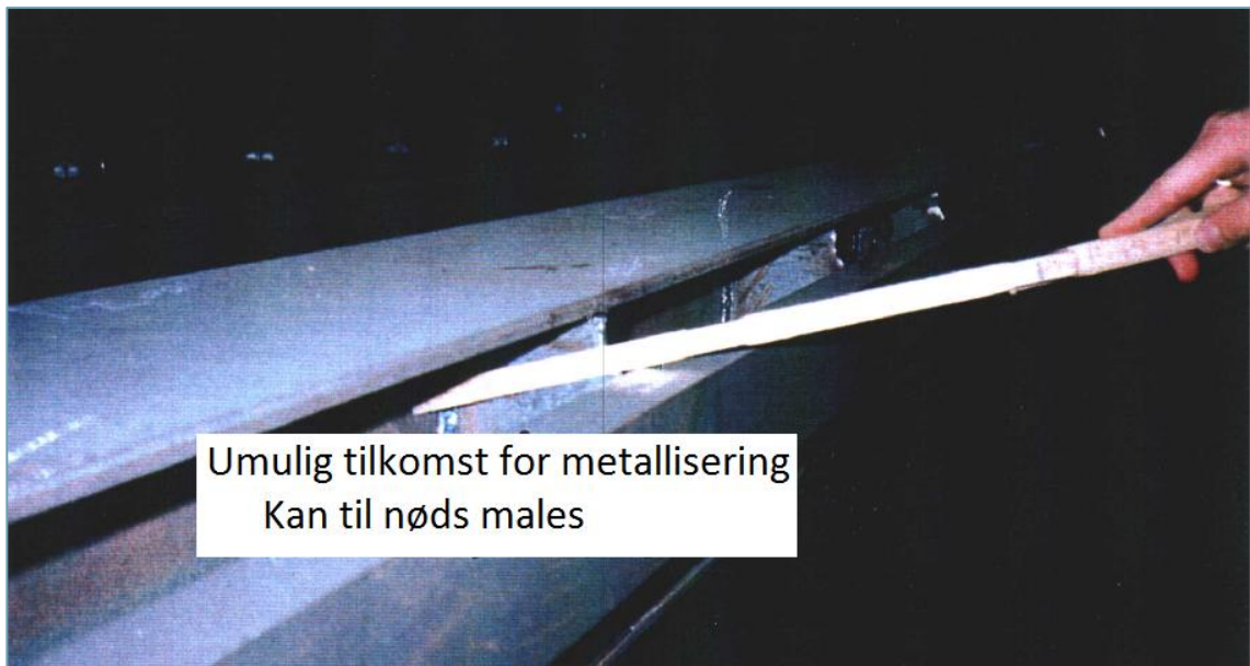
Figur 7.21: For trang konstruksjonsløsning
