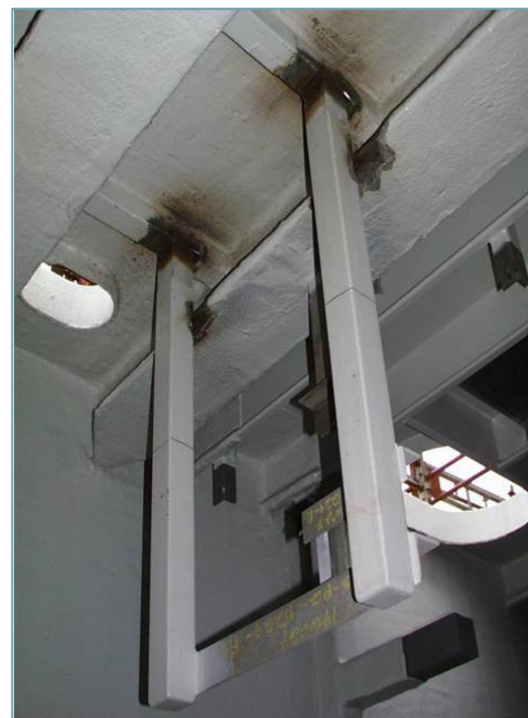
Figur 6.2: Ettermontert pipesupport
