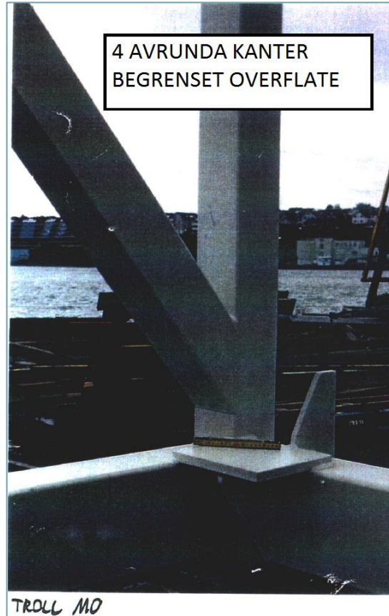
Figur 7.10: Struktur i RHS-profil
