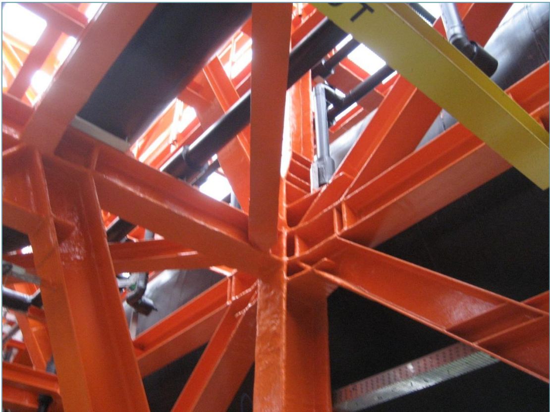
Figur 6.12: Bruk av H-profiler i "Kashagan"-prosjektet (2)
