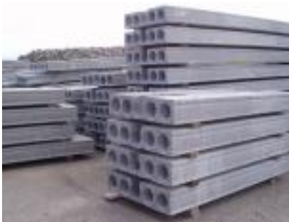
(Figur 3.3 viser mellomlagring av hulldekker)
