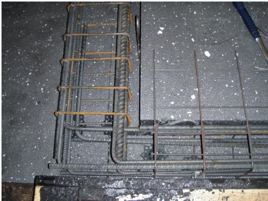
Bilde 6. Armering i hjørnet på et sandwichelement.
