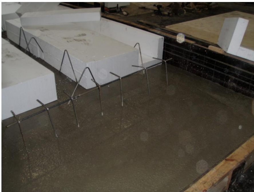
Bilde 5. Sandwichelement under produksjon hos AS Betong.
