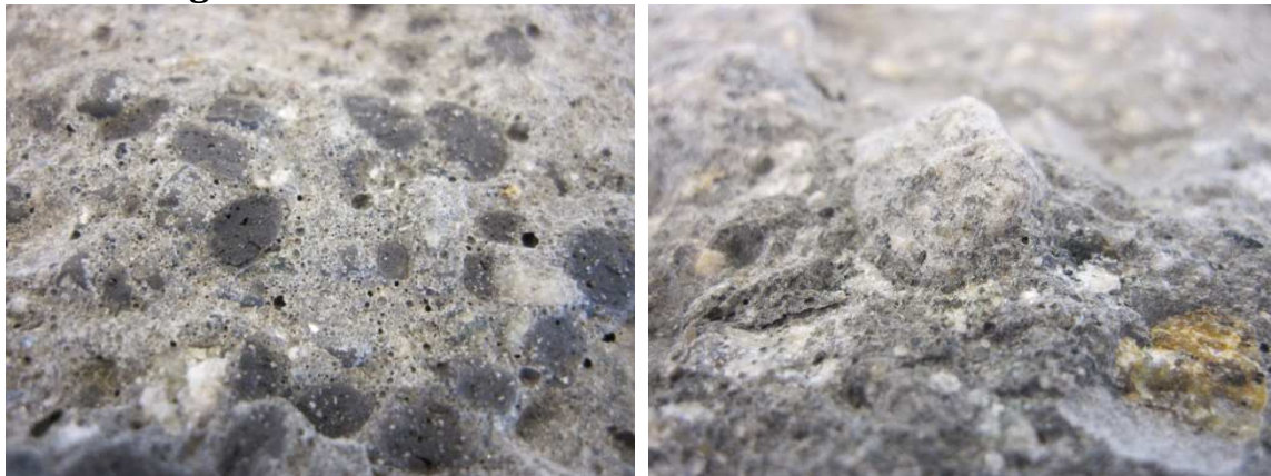
Figur 67: Tilslagsbruer, til venstre brudd i lett klinker og til høyre sikksakk mønster rundt pukkk
