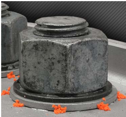
Figur 11: Ferdig tiltrekt DTI med silikonindikator
