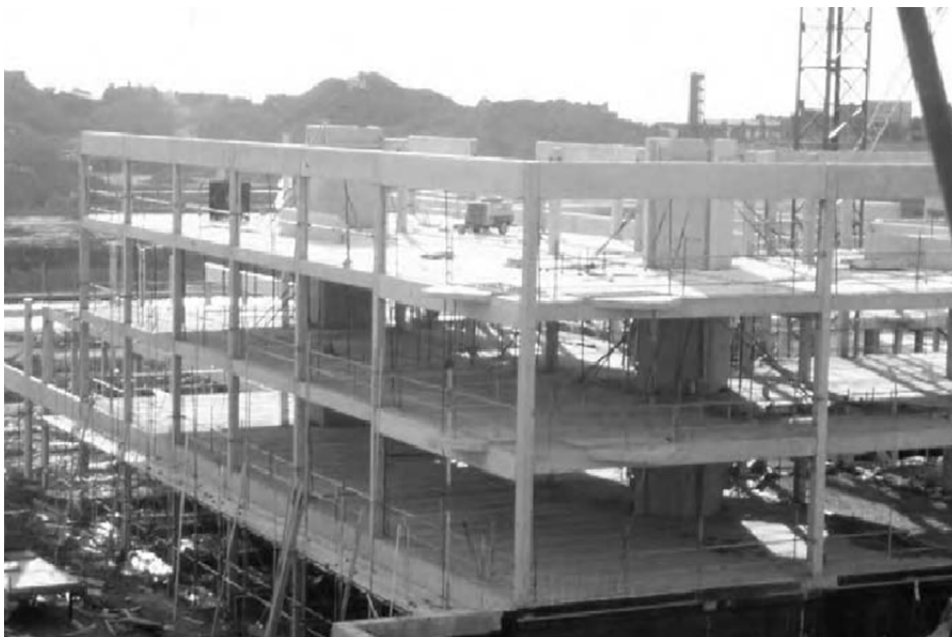
Figur 3. Skjelettsystem med avstivende sjakter [4]
