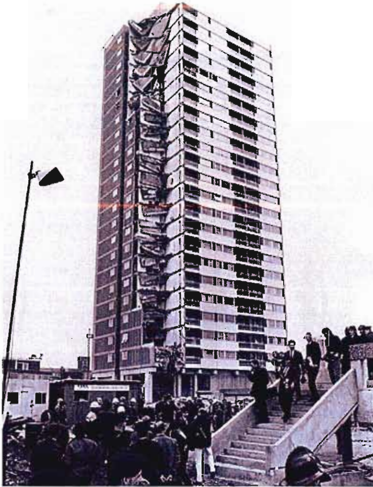
Figur 2-1 Kollaps av Ronan Point
