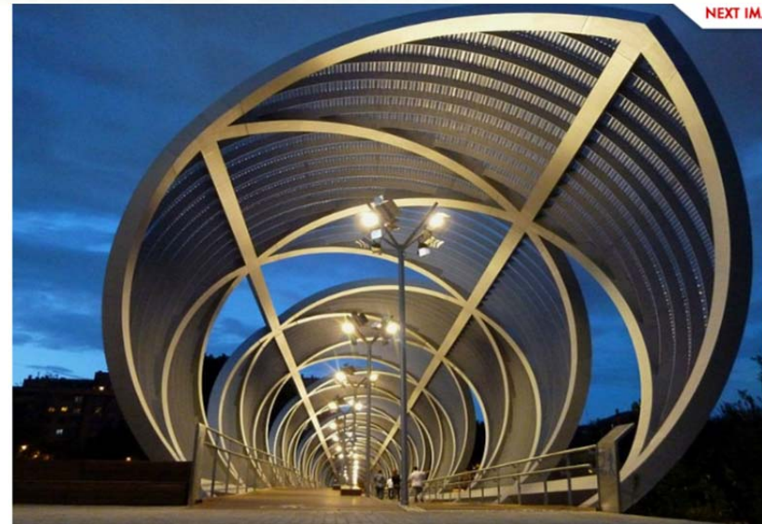
Figur 73 Arganzuela Footbridge. Foto: Georges Fessy, Ayuntamiento de Madrid
