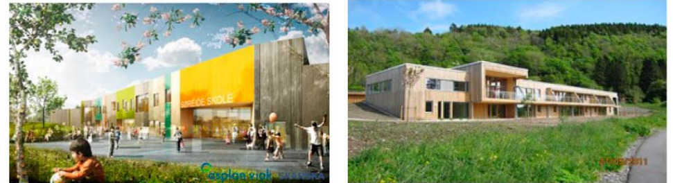
Figur 18. Søreide skole til venstre og omsorgsboliger i Rådalslien til høyre. Kilde:Byrådsak 274/13
