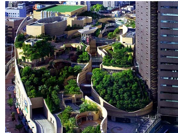
Figur 65 Namba Parks, Osaka. Uteområder kan bygges på toppen av bygninger. Kilde: Inhabitat.co
