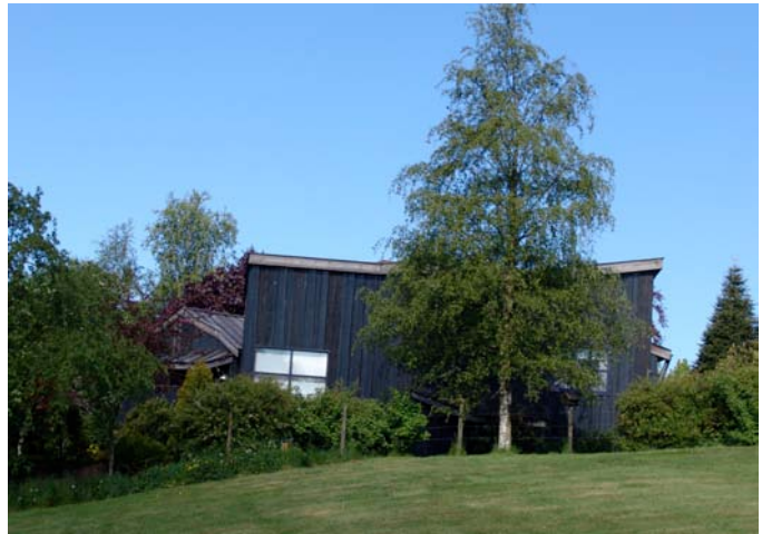
Bilde 13b: Østfasaden.
