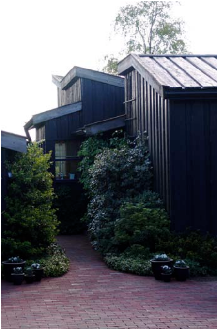
Bilde 13a: Detalj nordfasaden, hovedinngang.
