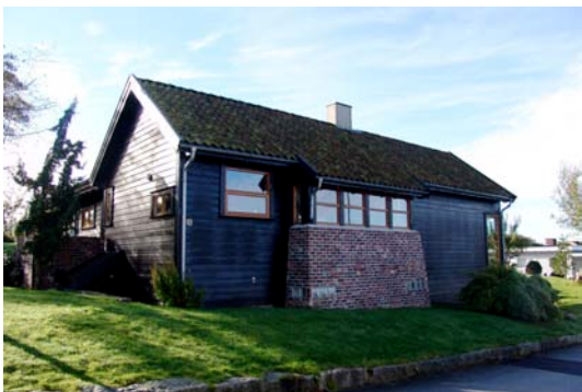
Bilde 23b: Nordfasaden.
