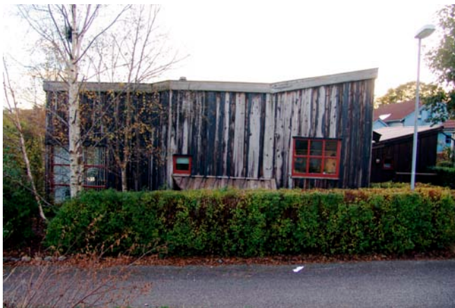
Bilde 14b: Østfasaden.
