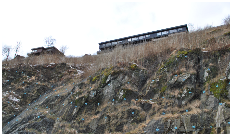
Figur 9: Skredsikring ved Hatlestad terrasse. Foto: Elisabeth Groven
