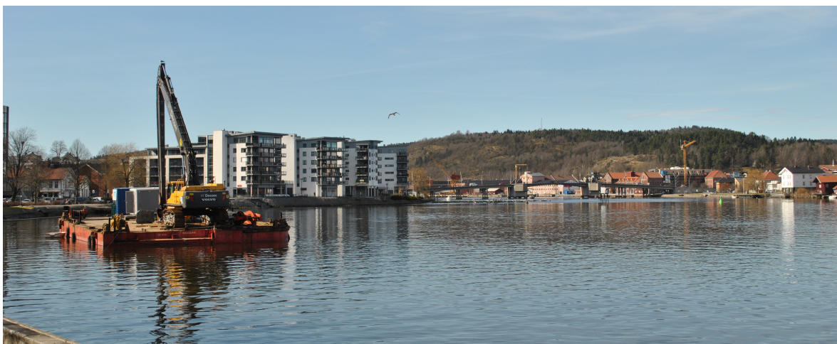
Figur 13: Gravemaskin på lekter driver med steinsetting av Porsgrunnselva. Foto: Elisabeth Groven.
