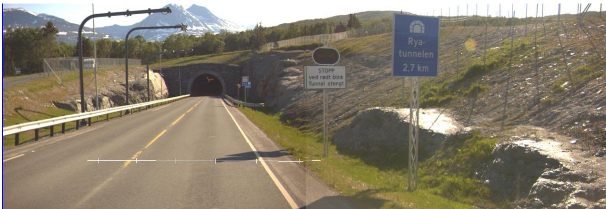
Bilde 1: Rya tunnel sett fra Larseng-siden, bilde fra Statens vegvesen, ViaPhoto, 2013.
