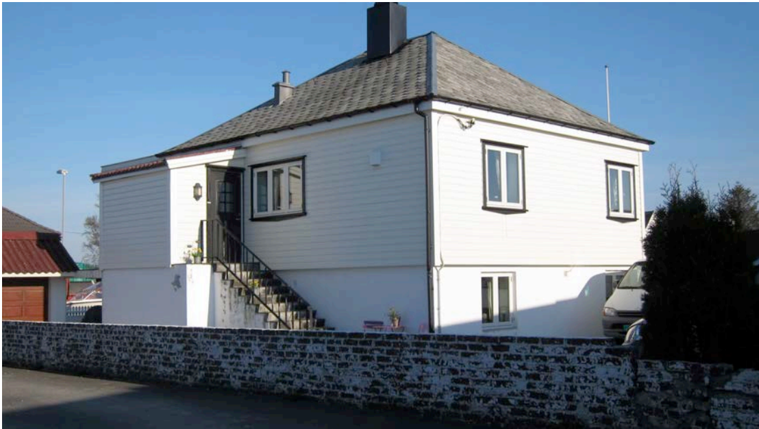
Foto 21: Et av arbeiderboligene ved Bø teglverk i Bøvågvegen. Bygget av Håkon Hagesæther i 1937. Foto: Evy Vikingstad
