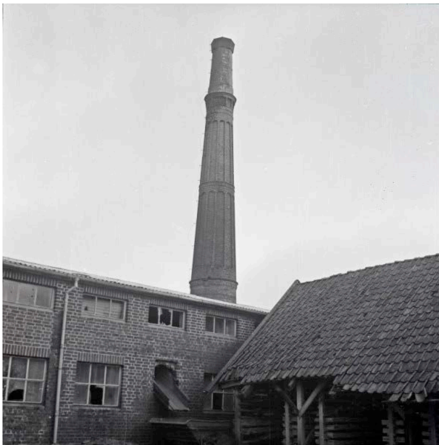
Foto 6: Ovnshuset med den høye skorsteinen.
