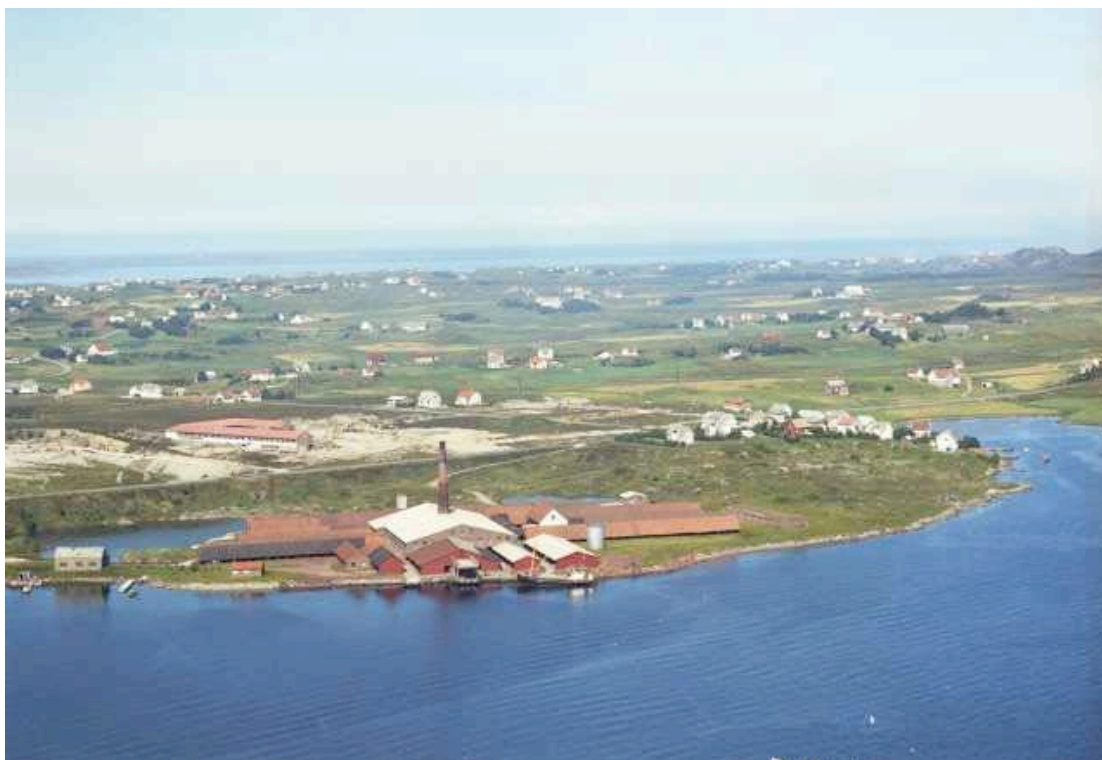
Foto 5: Bø Teglverk, Karmøy, 1966 eller 1967. 211
