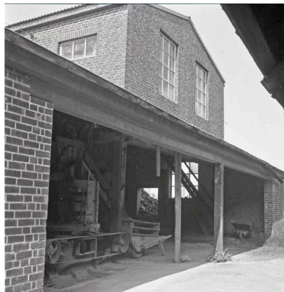
Foto 9: Valseverket og formingsmaskinen i 1. etasje på ovnshuset.
