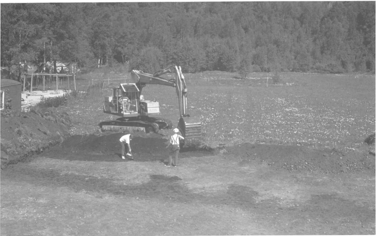
10. En typisk arbeidssituasjon under maskinell flateavdekking, jevnfør fig. 8f. Foto: Forsand-prosjektet. 10. Typical situation when an area is being stripped of topsoil by a digger; compare figure 8f. Photo: Forsand project.
