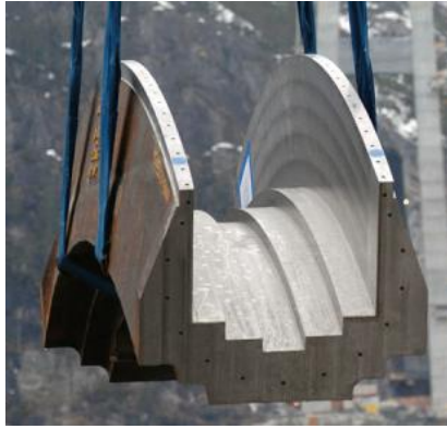
Figur 7: Tårnsadel, Hardangerbrua.
