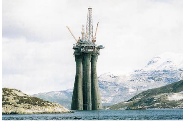
Figur 1: Troll A 245 000 kubikkmeter høyfast betong
