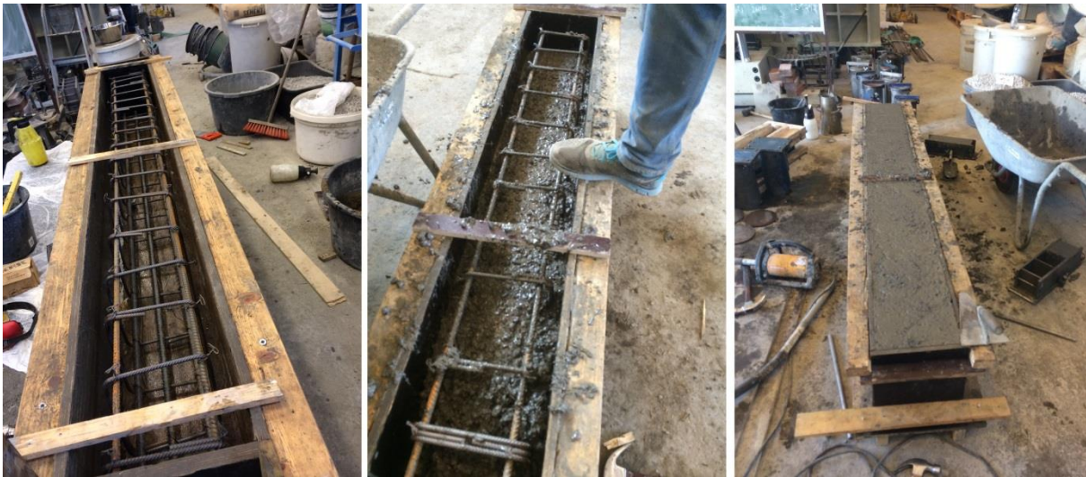
Figur 21: Til venstre: støpeform stor bjelke. I midten: halvfylt stor bjelke. Til høyre: ferdig støpt stor bjelke
