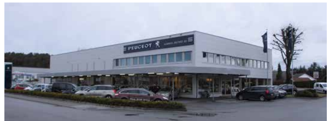
Bygget til Gabriel Østråt anno 2014. Bygget har gjennomgått en fasadeendring og er med på å heve verdien av et ellers slitt område.
