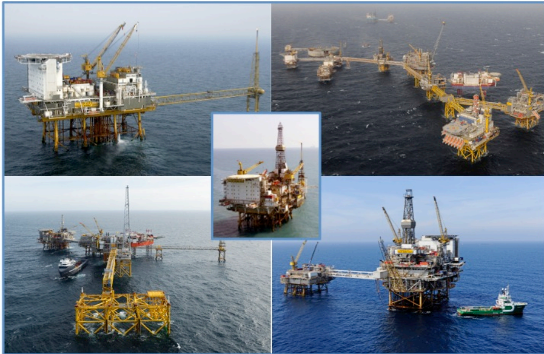
Figur 2-5 Installasjonene som inngår i studien: Tor (oppe venstre), Ekofisk Kompleks (oppe høyre) , Eldfisk Kompleks (nede venstre), Ekofisk K-B (nede høyre) og Eldfisk B (midten) (Foto: Kjetil Alsvik, ConocoPhillips)
