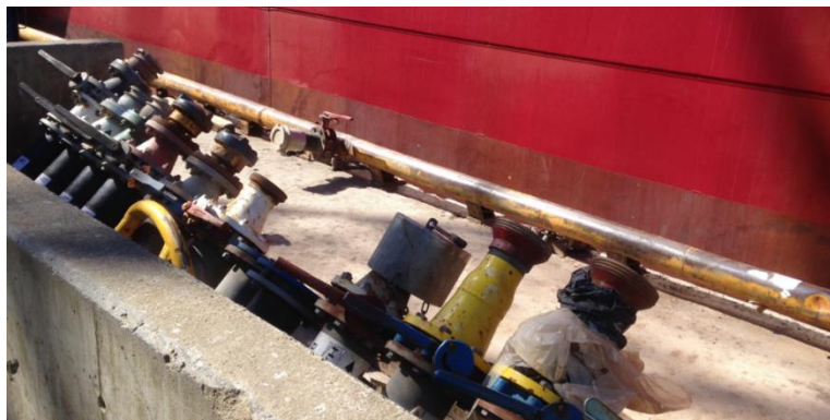
Figur 21 Rørgater sjøside kai 3
