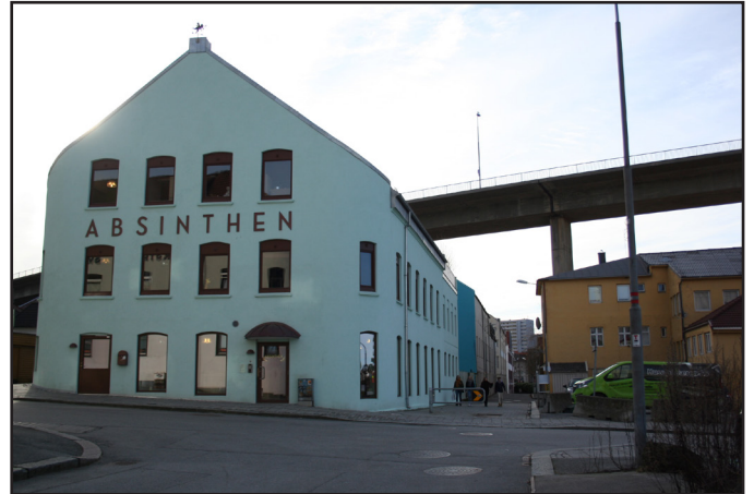
Figur 3.14 Eksempel på renoverte fabrikklokale i Nedre Banegate, Badedammen.
