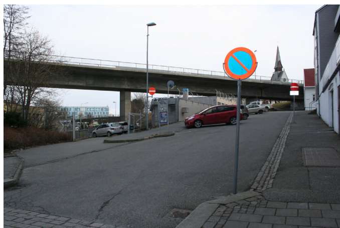
Figur 3.20 Gangsti under bybroa, sett fra Pedersgata
