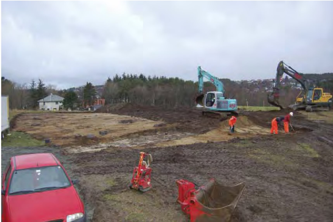
Figur 5 Undervegs i flateavdekkinga. Midt i bildet ser ein den delvis tomme maskintraséen. Mot NNV.
