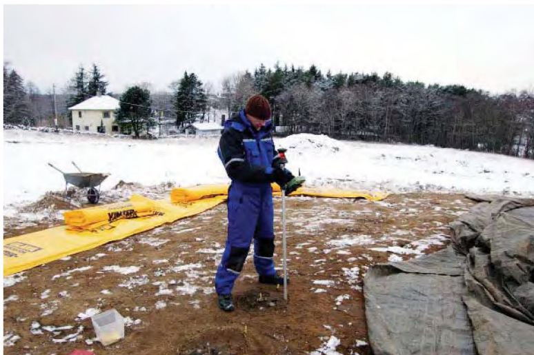
Figur 13 Feltleiar Bjordal i sving med totalstasjonen ved toskipa hus. Mot VNV.
