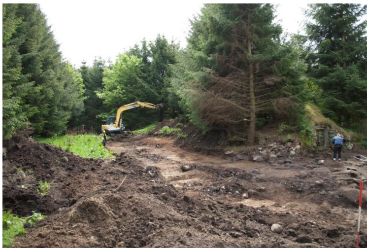
Fig. 7 Maskinell flateavdekking i området ved jordkjellaren. Mot S.
