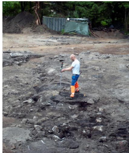
Fig. 8 Even Bjørdal brukar totalstasjonen
