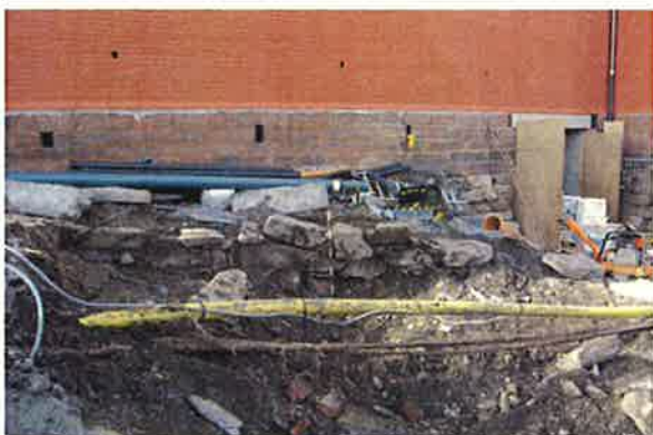
Fig. 5 Den sørlege delen av muren. Mot V.
