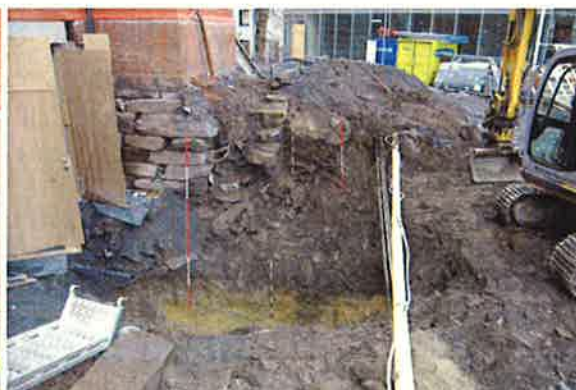
Fig. 4 Grøft og mur ved inngangen. Mot NNV.
