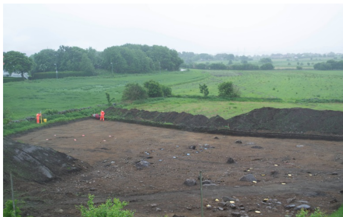
Figur 1: Oversikt over planområde etter avdekking og utgraving. Bildet er tatt mot vest.
