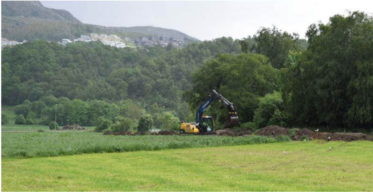
Figur 3. Oversikt om åpning av sjakt ved gravemaskin, mot syd. Foto DF 2016.
