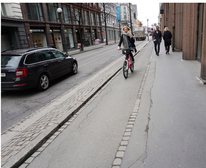
Figur 4.9 (2) Systemskifte til gang- og sykkelveg i Rådhusgata 2
