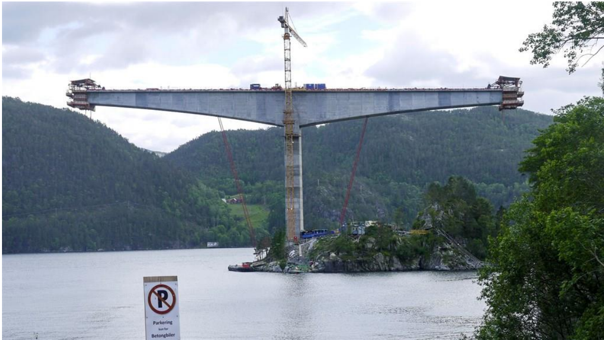
Figur 3-10 Fritt frambygg som byggemetode av Sandsfjordsbrua, [Foto: Tor Arne Thorsen, SVV]
