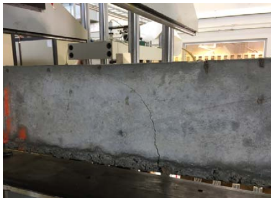
Figur 7.6: Riss ved punktlast for samvirkedekket med armering
