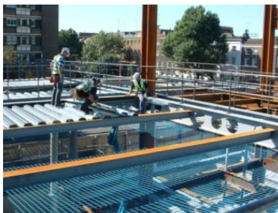
Figur 3.12: Stålplate installasjon [21]
