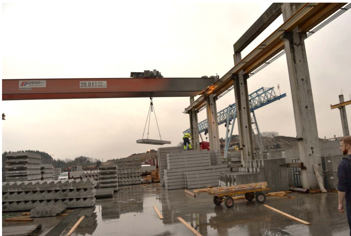
Figur 25: Håndtering av elementer på fabrikk, Block Berge Bygg Elementfabrikk
