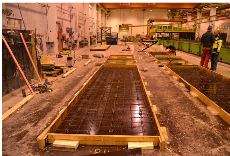
Figur 24: Armering av betongelement, Block Berge Bygg Elementfabrikk
