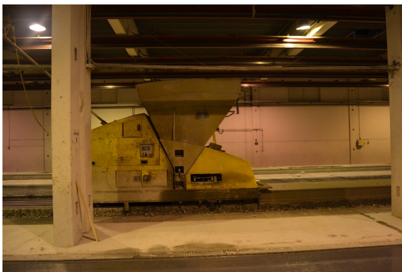
Figur 46: Produksjon av hulldekker, Block Berge Bygg Elementfabrikk
