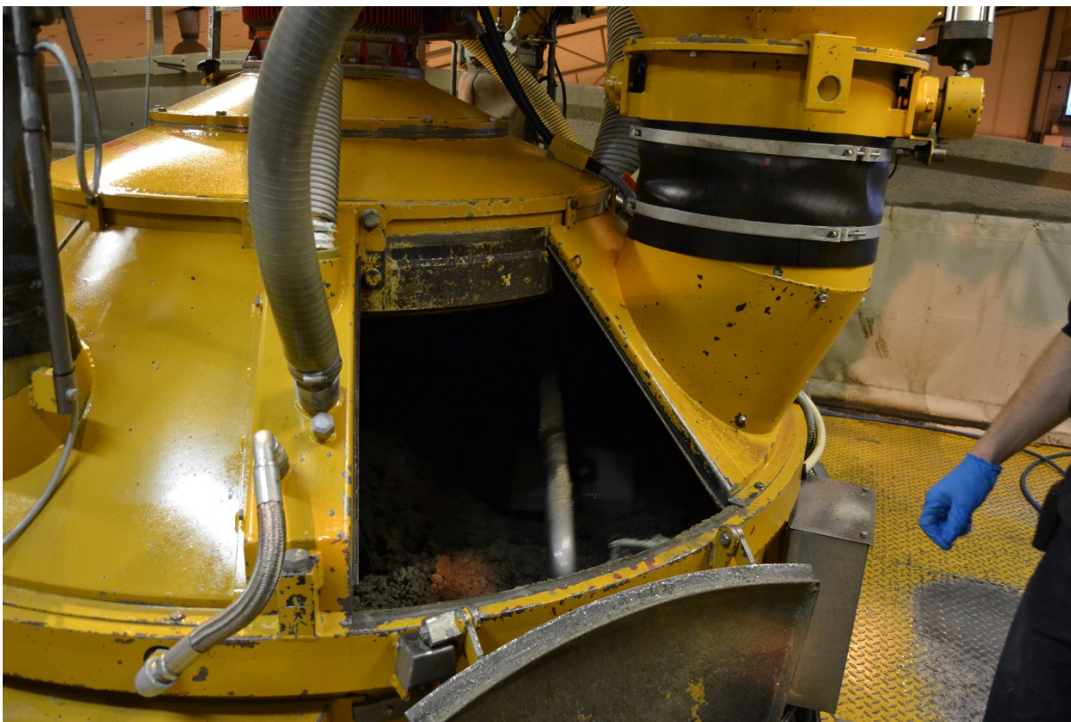
Figur 12: Blandemaskin, Block Berge Bygg Elementfabrikk
