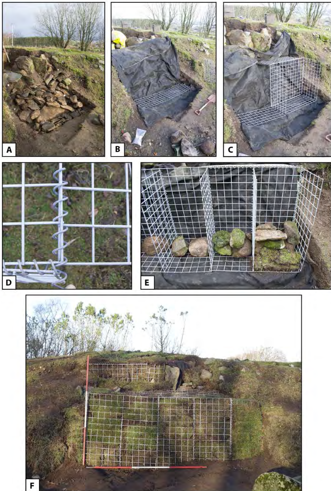
Figur 13: Stabiliseringstiltak. A: Gjenfylling av dreneringsgrøft og preparering av plan overflate. B: Veiduk under gabioner og langs profil. C: Bygging av gabioner. D: Detalj av bindingssystem. E: Fylling av gabioner, forsterket av to ekstra nettmur inni. Torvbriker på utsida og steiner inni. F: Ferdig resultat.
