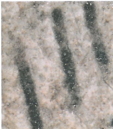
Fig.16. Porer i trestrukturen som er synlig på overflaten
