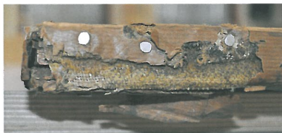
Fig.18. Nedre høyre hjørne. Stifter påsatt for å sikre heft i hjørnene mellom lerret og blindramme.
