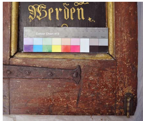
Fig. 34) Slitasje og støtskader i nedre del av høyre fløydør.
