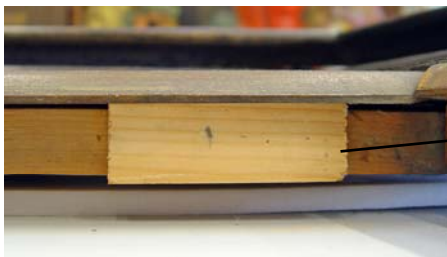
Figur 22) Ny trekloss i nedre kant av prydrammen som stammer fra en tidligere behandling, trolig etter 1980.
