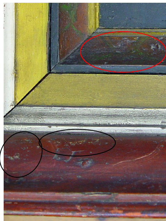
Figur 33) Flere små avskallinger på prydrammen (i sort sirkel) og blanching -lignende misfarging (markert med rød sirkel).
