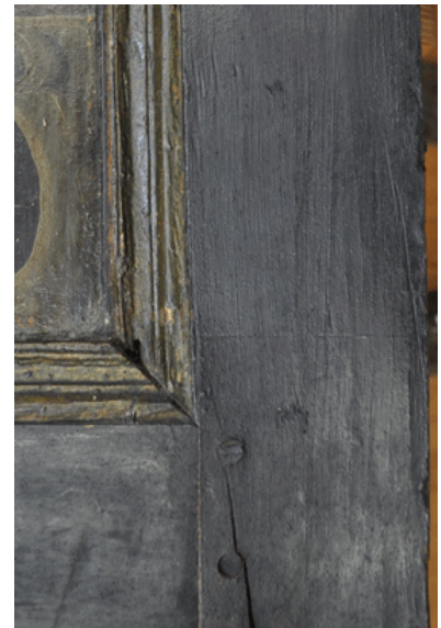
Fig.16. Prydrammens nedre venstre hjørne med løst trestykke.
