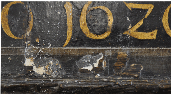
Fig.19. Detalj fra nedre del av skriftfeltet under fjerning av tidligere kitting, som delvis var påført inn på original maling.
