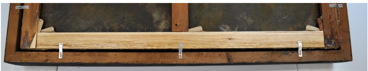
Figur 39 Nedre blindrammeliste erstattet med ny
